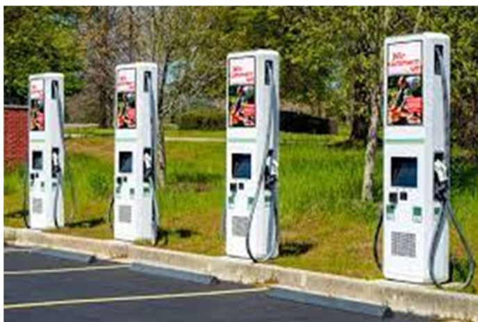
Figura 14 – Exemplu de stație de încărcare dubla, de puteri diferite (50kW + 22kW)
